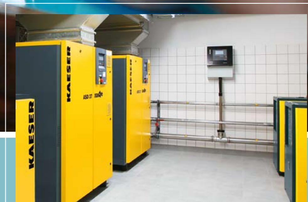
Precizní práce – stanice stlačeného vzduchu u firmy Chopard je vzorem uspořádané čistoty a účinnosti, k tomu rozhodujícím způsobem přispívá „Sigma Air Manager“ založený na bázi průmyslového PC.
