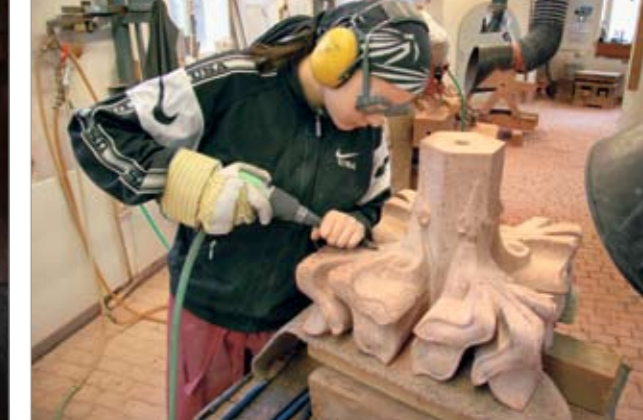
Výroba nových dílů ve stavebním ateliéru
