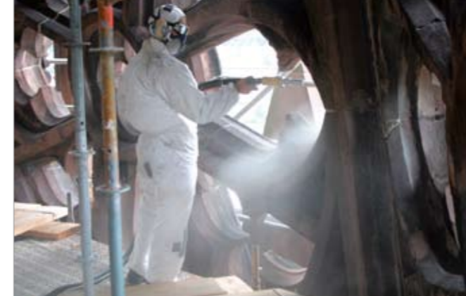
Čištění vrcholku věže
