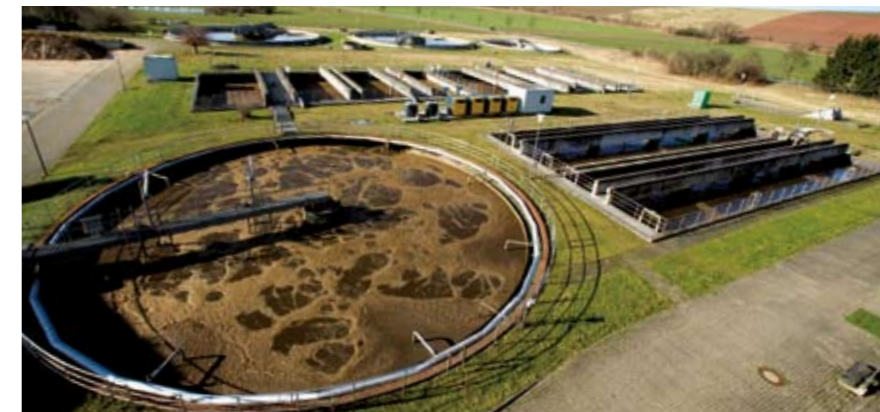
Aktivační nádrž v čistírně odpadních vod Scharzfeld/Harz (vpravo)
